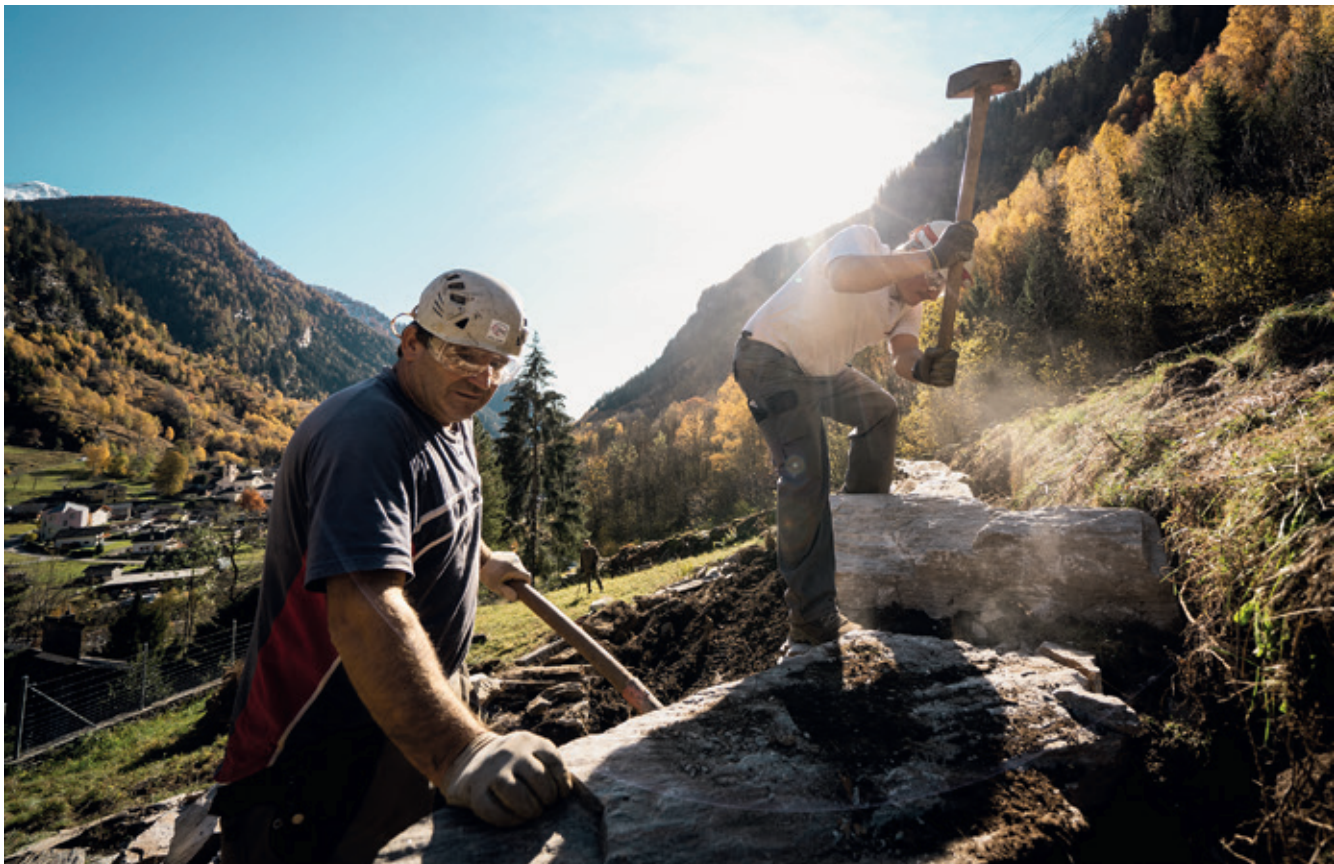
Instandsetzung von Trockensteinmauern im Parco Val Calanca (Kandidat).
